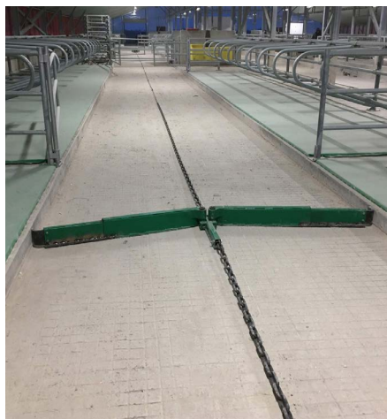
РИС. 16. УСТАНОВКА НАВОЗООБОРОЧНАЯ СКРЕПЕРНАЯ УНС-1 (170 М)
